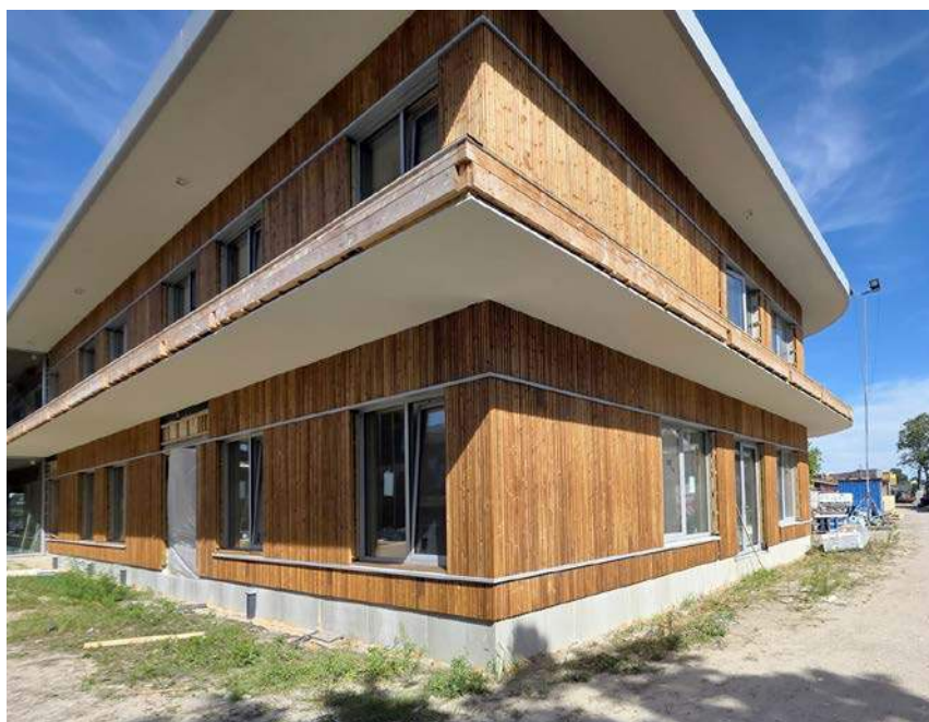
Hout is prominent aanwezig in zowel het interieur als de gevel.
